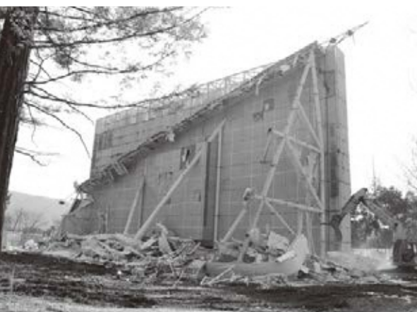
▲計画地では既存建物の撤去作業が進む（蒲生・2月20日撮影）
