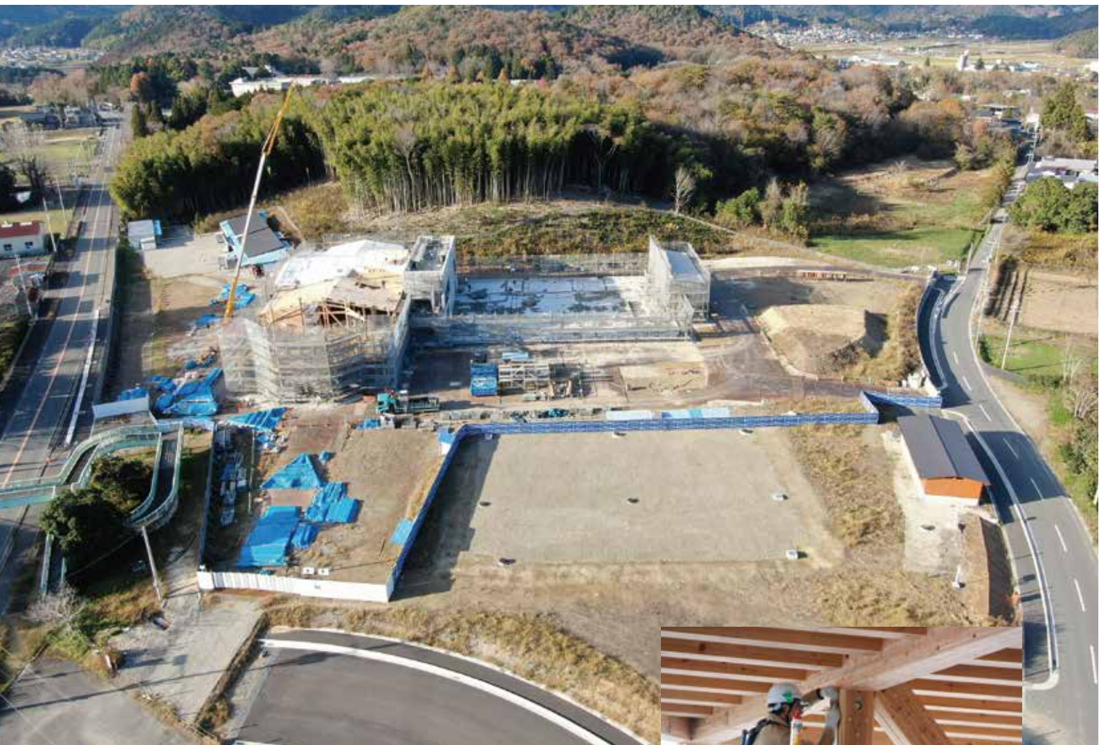
建設中の新庁舎
