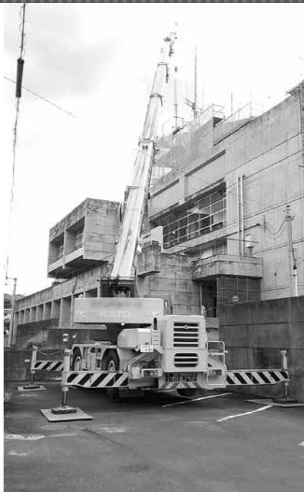
耐震工事中の和知支所
