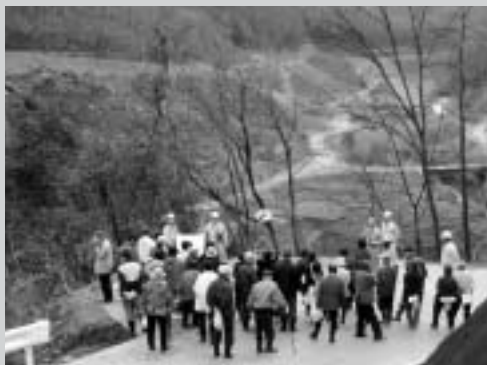
畑川ダム建設現場（下山地内）
