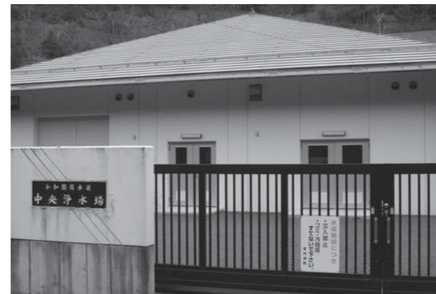
和知簡易水道事業で整備した中央浄水場（下乙見地内）
