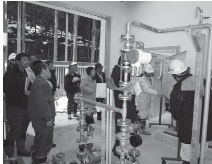
整備された水道施設の内部を踏査する委員（上谷簡易水道施設・才原）
