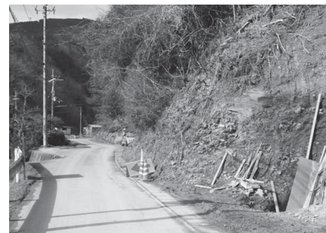
利便性向上と安全な道路環境を目指して、町道の新設や改良工事を順次進めています。写真は、継続事業として拡幅工事を行っている町道北山線(上大久保地内)
