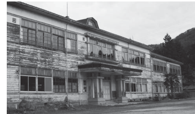
本年度予算において、老朽化し危険な状態となっている旧和知第二小学校校舎の解体工事を予定しています。
