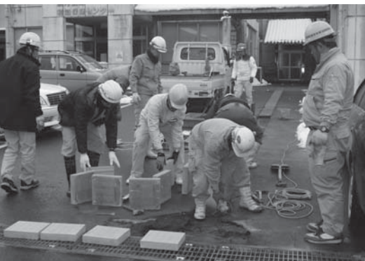
点示ブロックの張り替えを行う青年部員(社会福祉協議会和知支所・本庄)
