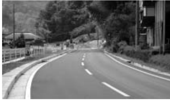
町道東又線改良(東又地内)
