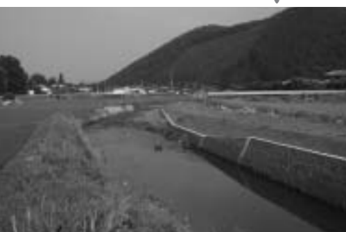
瑞穂地区橋爪の高屋川改修。植生護岸など生態系にもやさしい川づくりがすすんでいます
