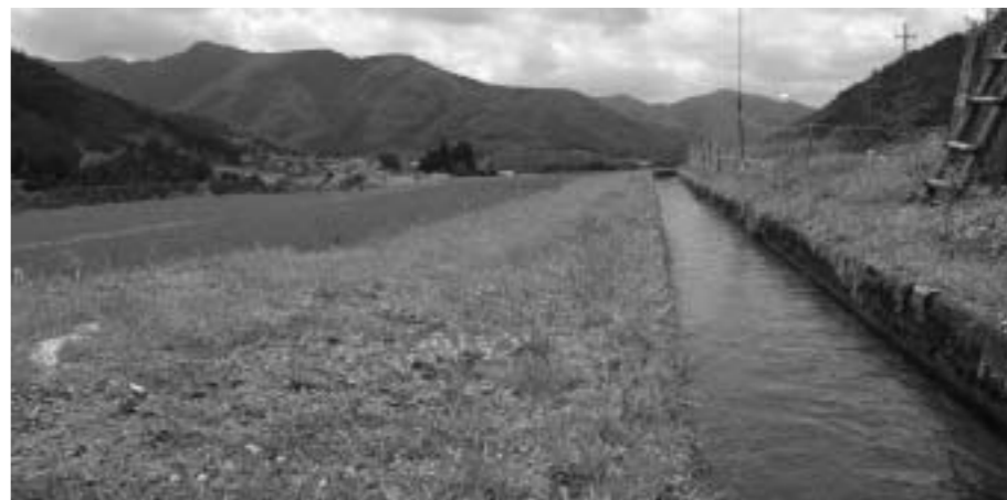
子来井根（篠原）。対岸の大迫にも総延長3,300メートルの「大迫井根」が開削されました。1802年（享和2年）のことです
