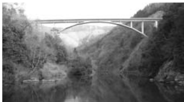
長瀬大橋。逆ランガーアーチ形式の橋は近畿でもこの長瀬大橋だけ
