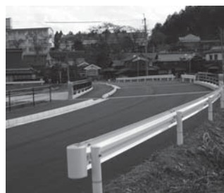
新設改良工事を行っている町道田中垣内線(瑞穂地区和田)。今年度、一部供用開始予定です。
