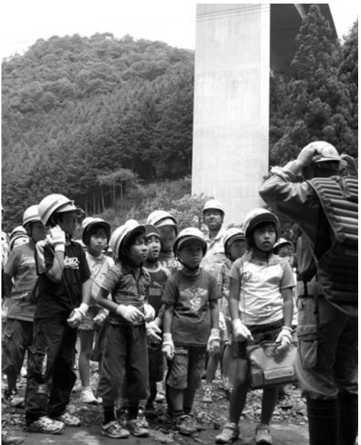
畑川ダムの工事現場を見学する下山小学校の児童
