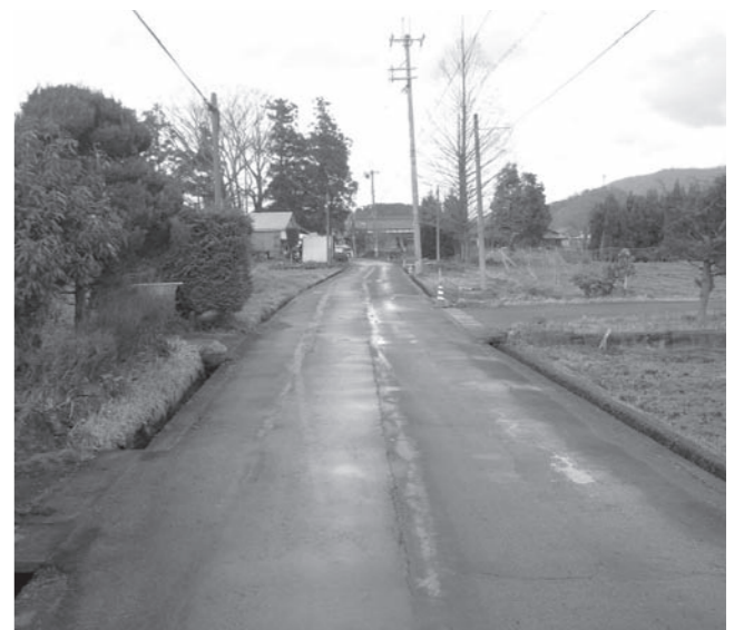
安全な道路環境を目指して、町道の新設や改良工事を順次進めています。写真は、本年度に新設改良工事を計画している町道院内中央線(院内地内)
