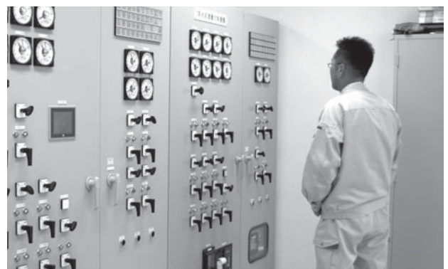
施設の点検を行う職員(瑞穂浄化センター・橋爪)
