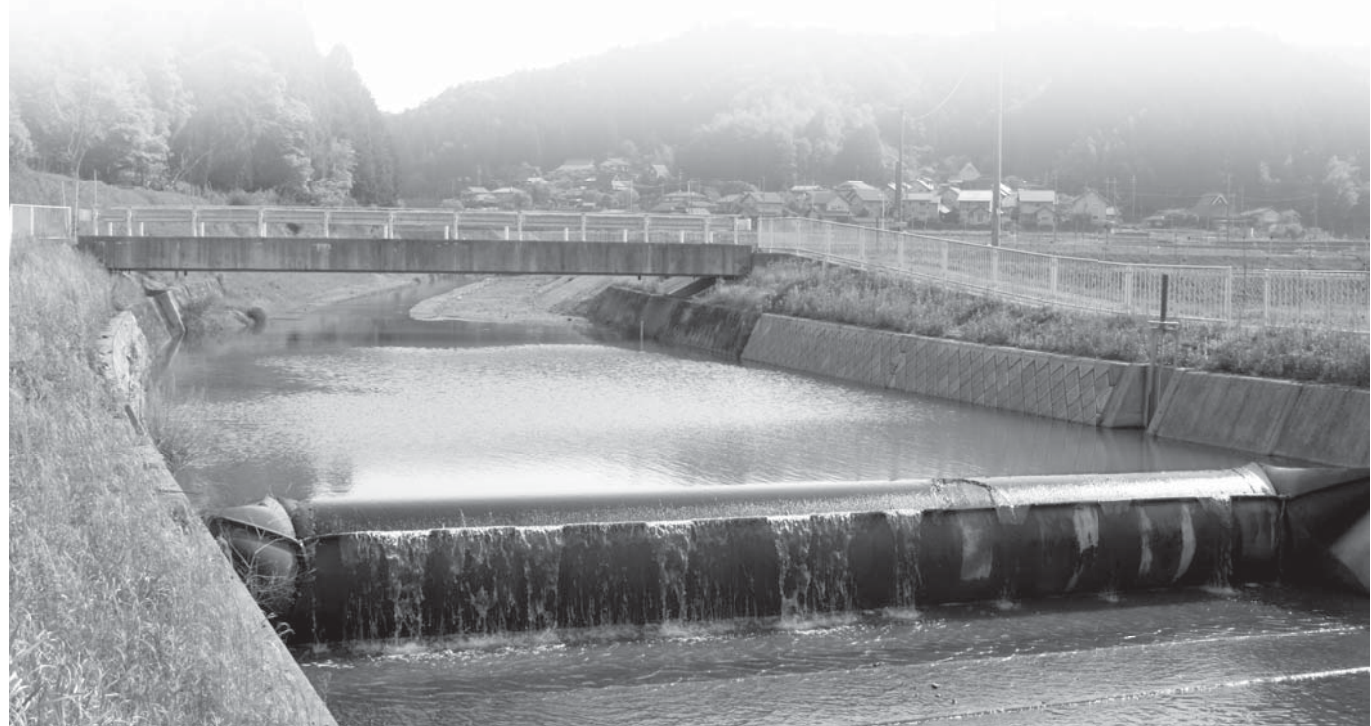
改修された須知川と高岡井堰(下村地内)
