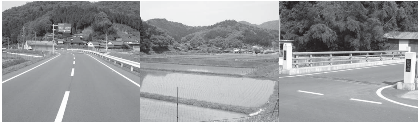
新設された一般府道篠山京丹波線・中畑バイパス(中畑地内)
