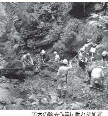
流木の除去作業に励む参加者(権現谷溪谷道付近・仏主)
