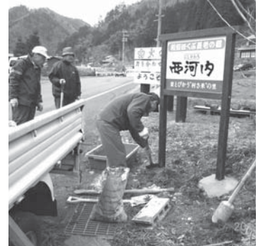
立て看板を設置する会員(西河内地内)
