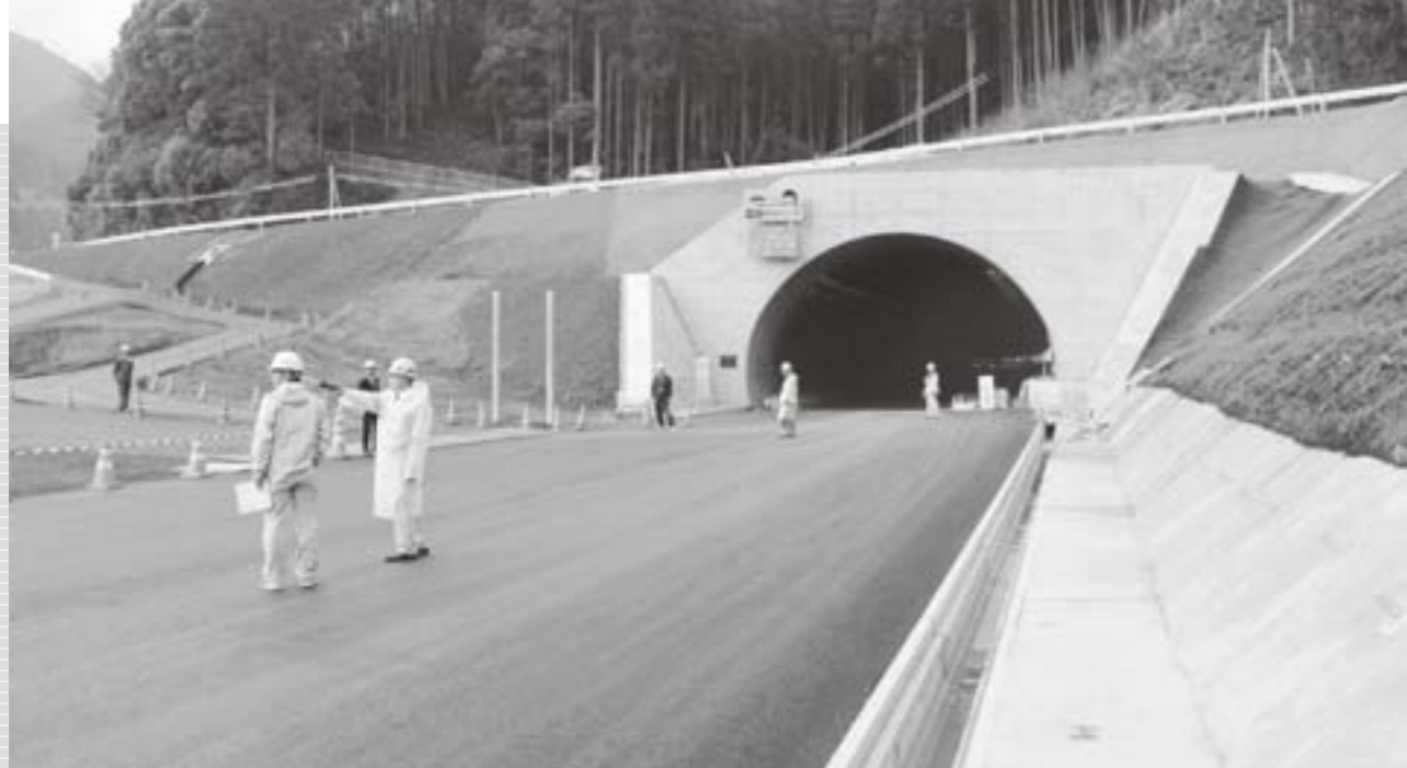
貫通した瑞穂トンネル(水呑)
