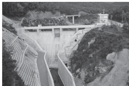
本体工事が完成し、試験的に満水まで水をためる「試験湛水」中の畑川ダム
