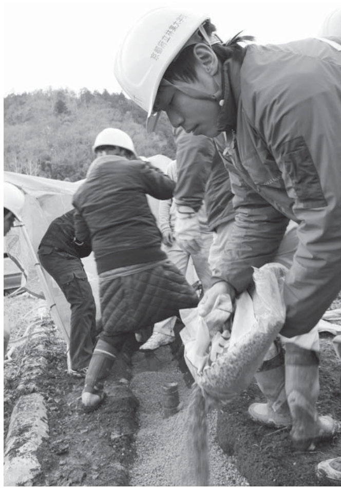
掘った穴に土壌改良資材を入れる学生
