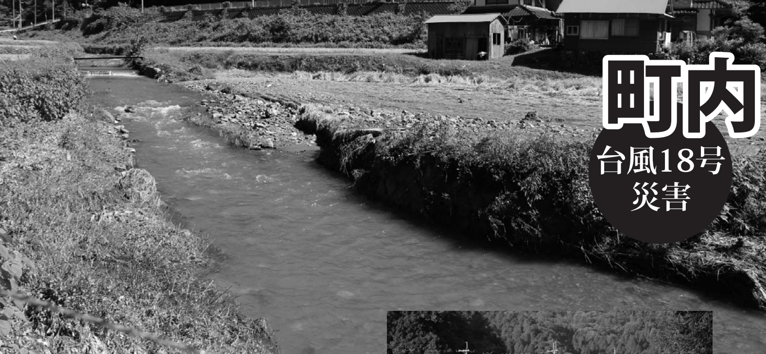
護岸が崩れ、濁流に押し倒された農作物（質志）
